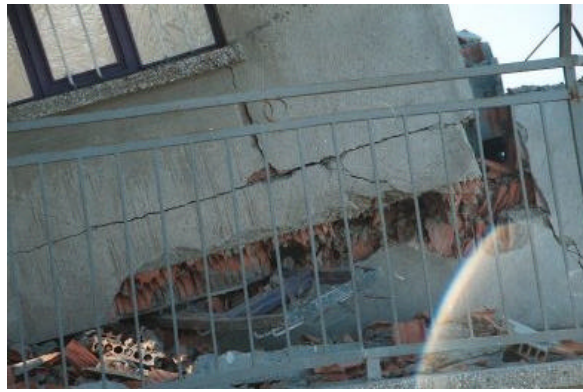
Zayıf boşluklu tuğla ile inşa edilmiş bir yığma yapı
