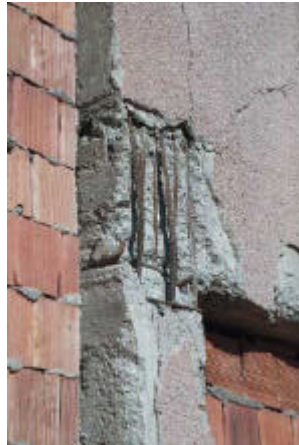
Zayıf boşluklu tuğla ile inşa edilmiş bir yığma yapı
