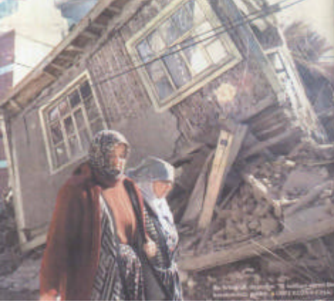
Eber kasabasında (15 can kaybı olmuştur) yıkılmış bir himis yapı (ahsap dikmeler arasında çapraz payandalar kullanılmamış, köse ve duvarlarda ise kenetlenme yok !)
