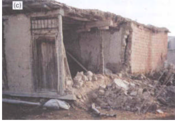
Sultandagi, Eber ve Çobanlar'da yıkılan derme çatma yapılmış himis yapı örnekleri
