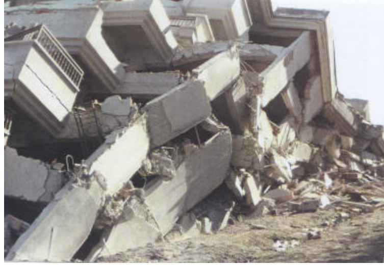
Çay-Bolvadin yolu üzerinde yer alan, tamamen yıkılmış 8 katlı apartman (Yesilçay kooperatifi 3.blok)
