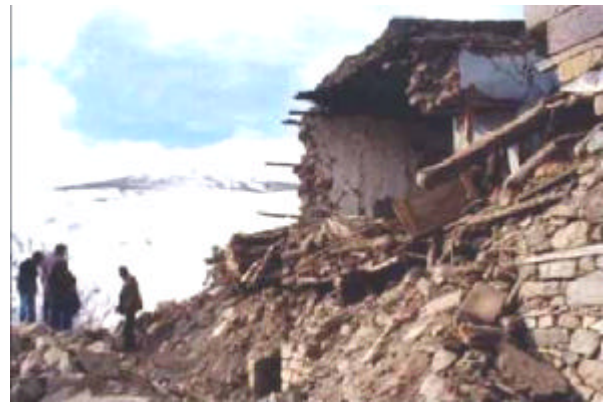
Çökmüş çamur harçlı tas/kerpiç yigma yapılara (himis) örnekler
