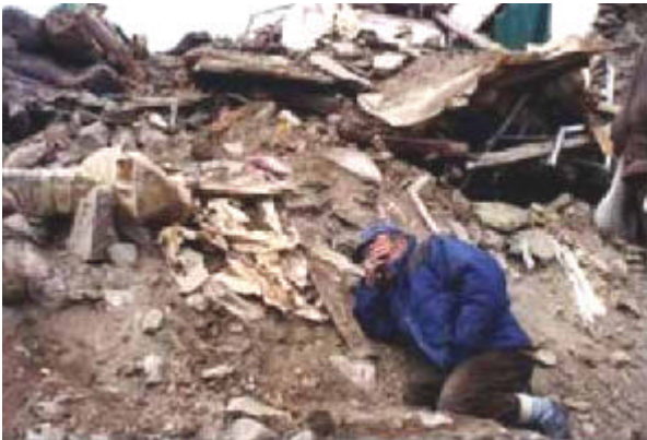
Çökmüş çamur harçlı tas/kerpiç yigma yapılara (himis) örnekler
